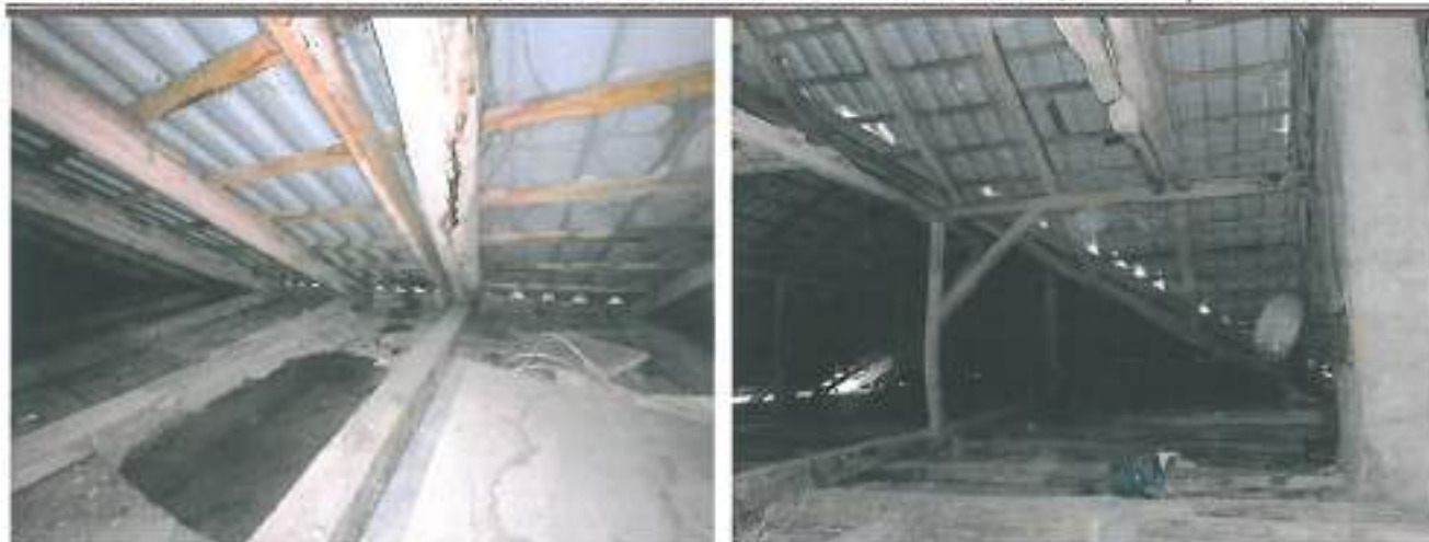
Imagine 3, 4, 5, și 6. Șarpantă din lemn, învelitoare din tablă
